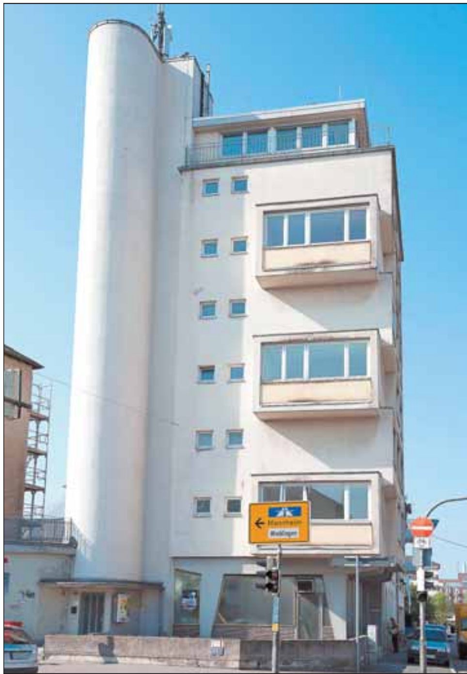
Der Verein „formAD“ will im ehemaligen Hotel Metropol in Bergheim ein Zentrum für Design und Architektur einrichten. Das IBA-Kuratorium machte die Idee zum Projektkandidaten. Foto: Joe
