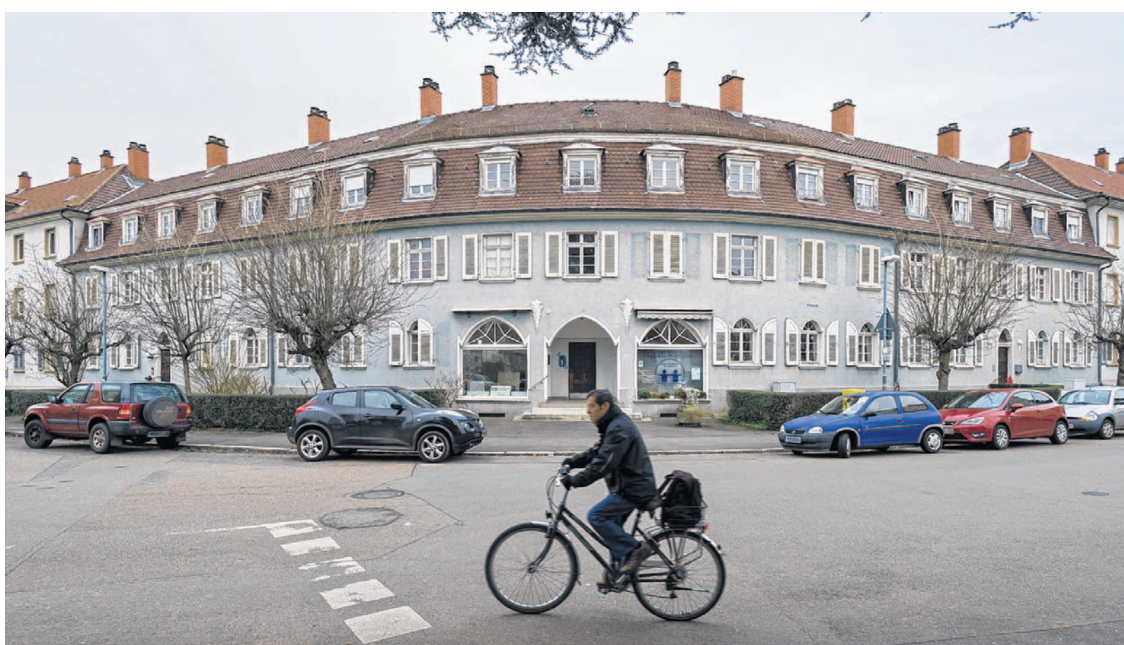
Anlass des Streits: Die Wohnanlage „Blaue Heimat“ in Handschuhsheim wurde von der GGH in den vergangenen Jahren stückweise saniert.
